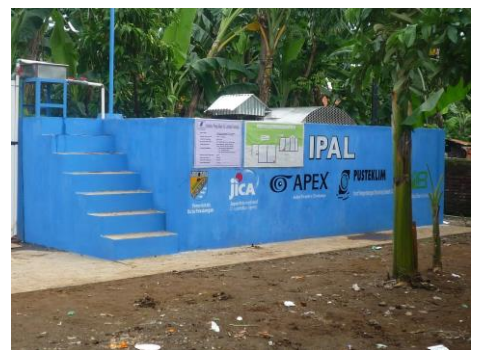
嫌気性と好気性を組み合わせた コミュニティ排水処理プラント(プカロンガン市)
