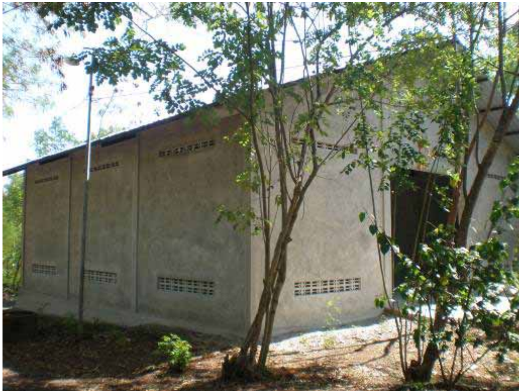
写真 14. ジャトロファ・センターに建設された種子保存用倉庫(2009年4月23日)
