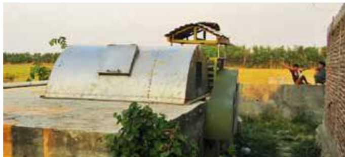
インドネシアにおけるコミュニティ排水処理システム 熱帯の気候に適し、安価で運転が易しく、かつ処理水質の高いシステムとしている
